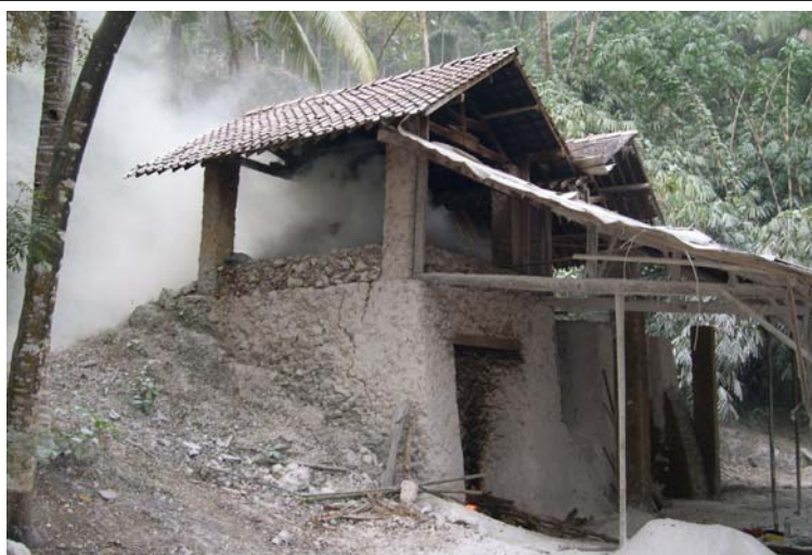
Four à chaux à deux cuves
